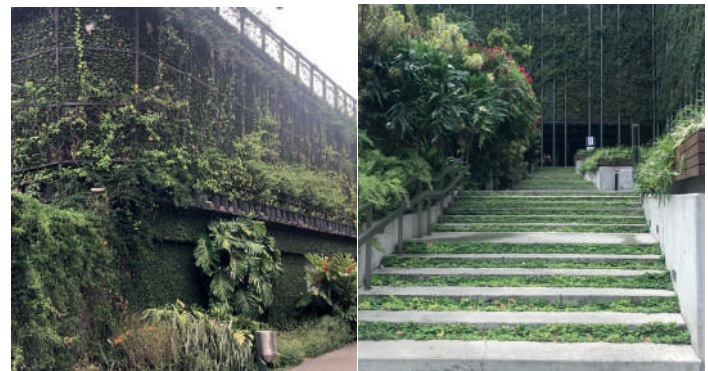
Distrito Térmico Alpujarra, EPM, Medellín. Foto: autor Edificio Ruta N, Medellín. Foto: autor
