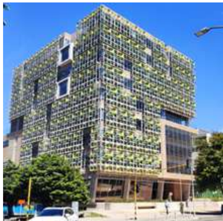
Ilustración 1. Edificio EAN Legacy. Fuente: Universidad EAN.
