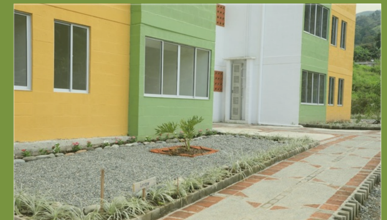
Foto 4. Sistemas de antejardines que ayudan a la gestión de la escorrentía del proyecto El Paraiso. Créditos SYMA Consultores y Constructores
