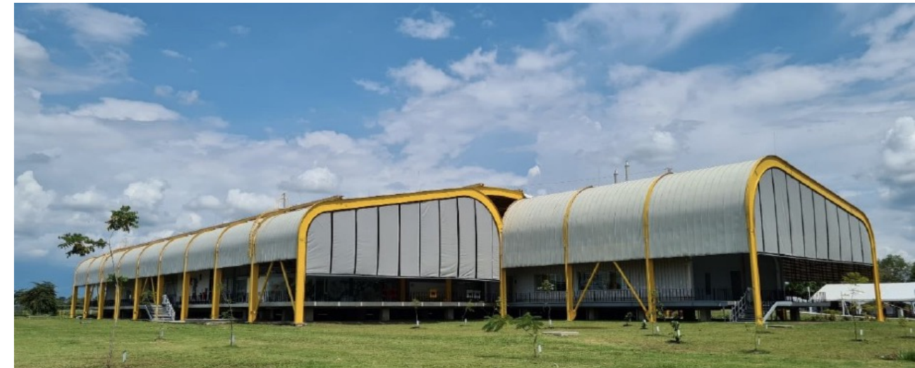
Foto 7. Vista general CIAT. Créditos Green Loop
