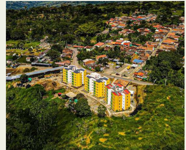
Figura 117. Proyecto El Paraíso . Fuente: SYMA Consultores y Constructores
