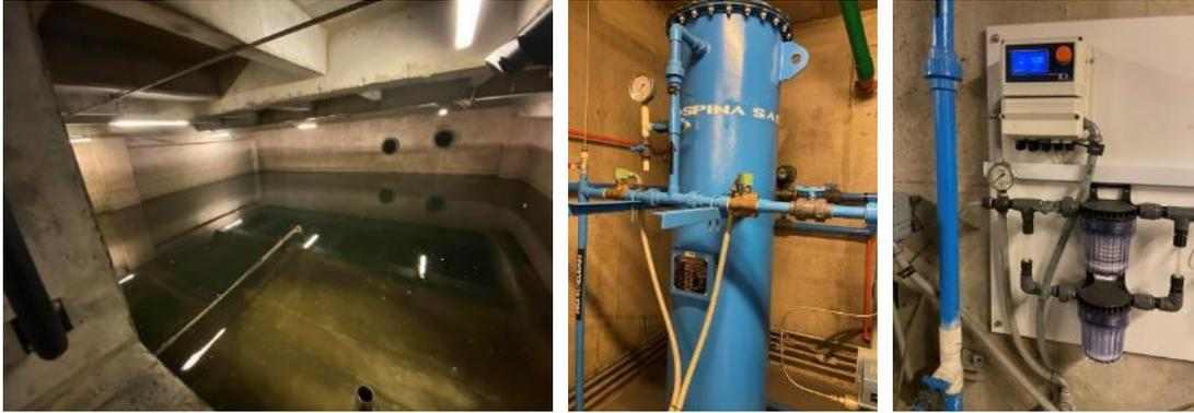
Ilustración 4. Sistema de captura y tratamiento de agua lluvia.
